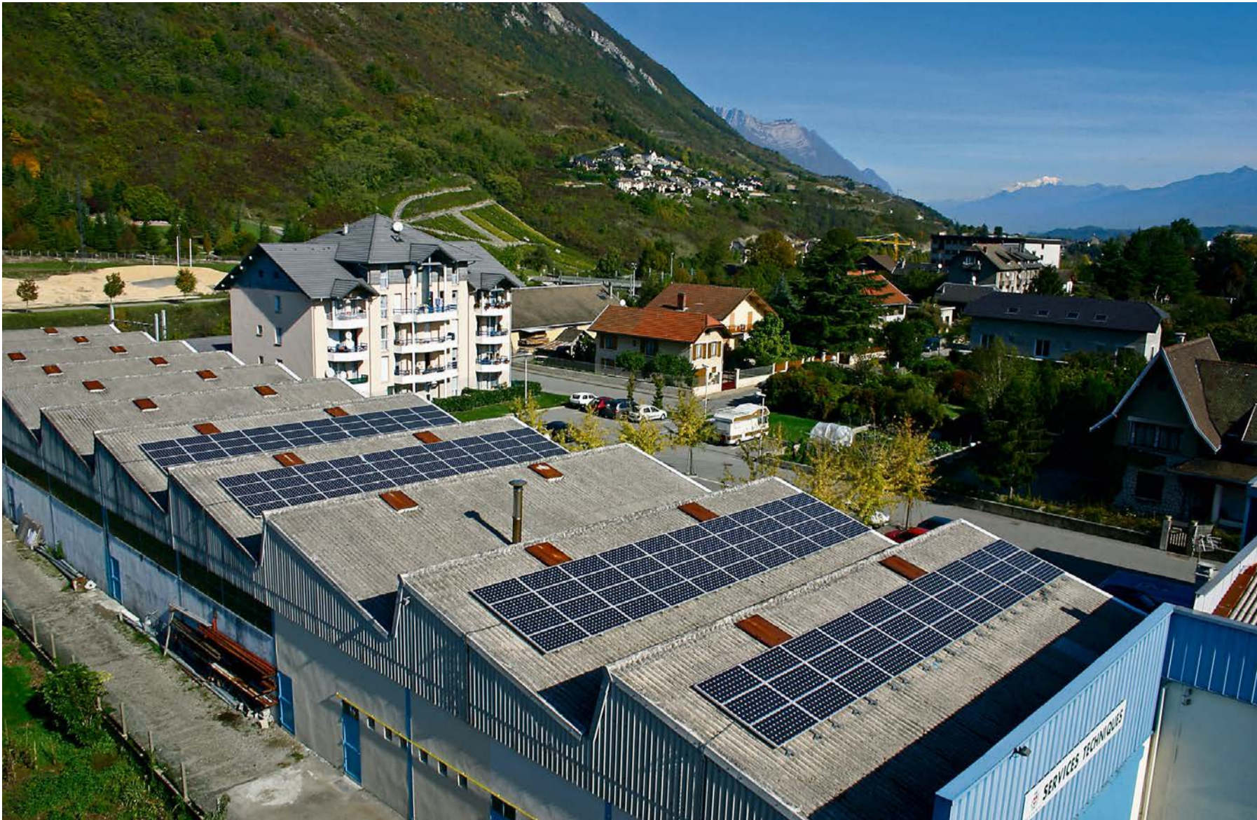
La toiture des ateliers municipaux est couverte de 240 m 2 de panneaux photovoltaïques, qui produisent l'équivalent de la consommation des services techniques de la ville et des quatre véhicules électriques municipaux.
