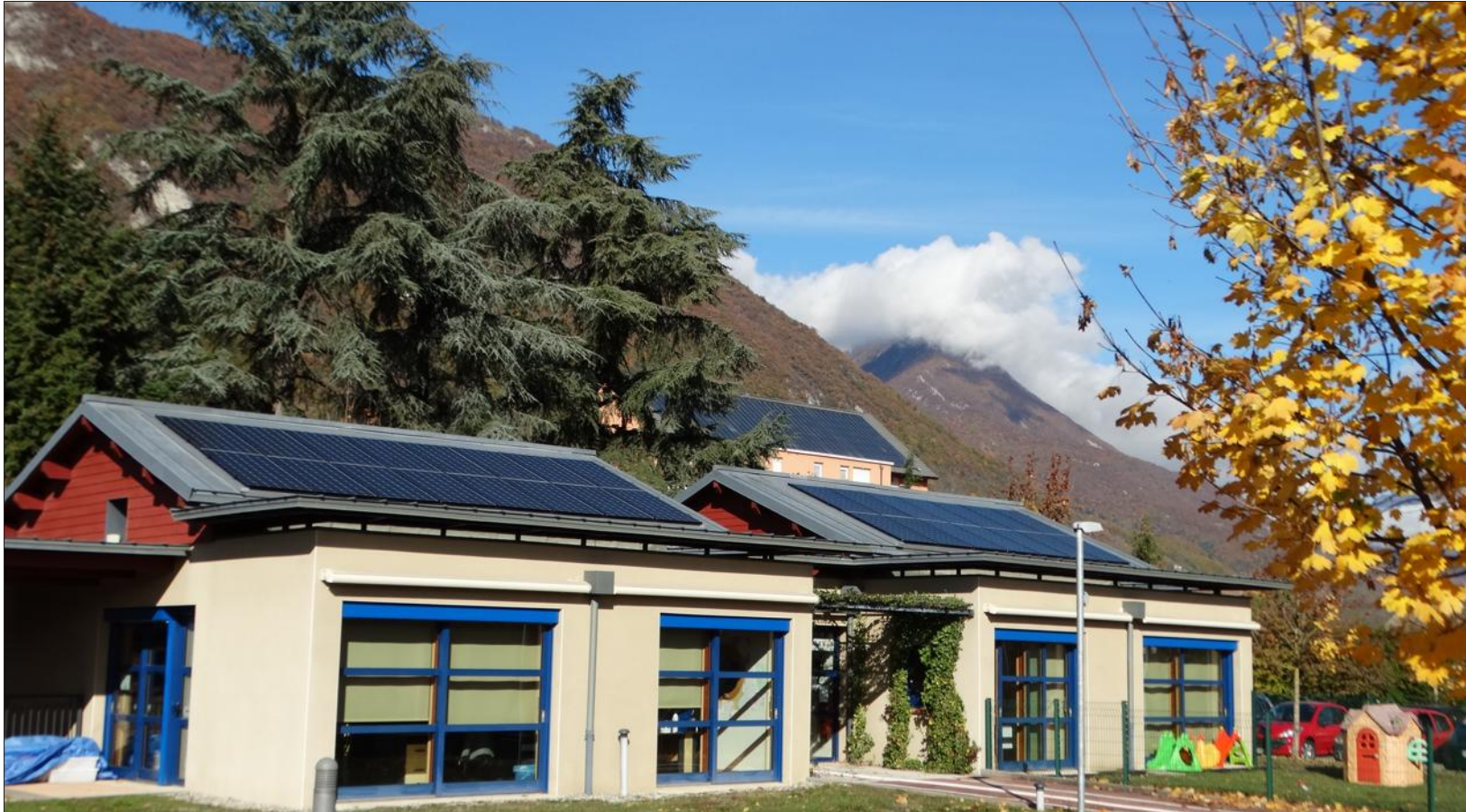
Le Solaret compte 13 toitures équipées de panneaux photovoltaïques, pour une surface totale de 850 m 2 et une production annuelle de 165 600 kWh. Ici, l'installation du Relais d'assistants maternels de Montmélan, qui produit 9 kWc. C'est plus que les estimations. Photo Le DL/C.C.
